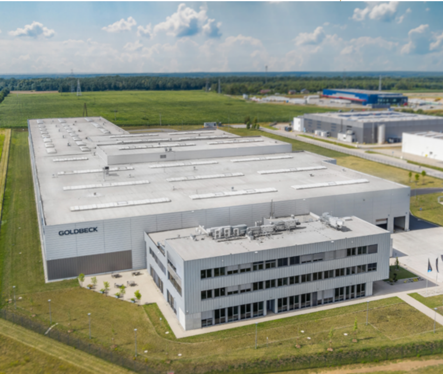
Hala produkcyjna GOLDBECK Elementy w Lucmierzu, produkcja konstrukcji stalowych.
