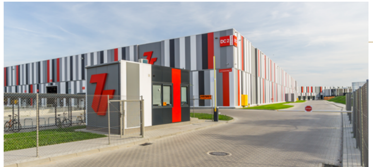
Hala logistyczna dla 7R w Poznaniu. Powierzchnia: 31 000 m 2 hala + 1000 m 2 biura.
