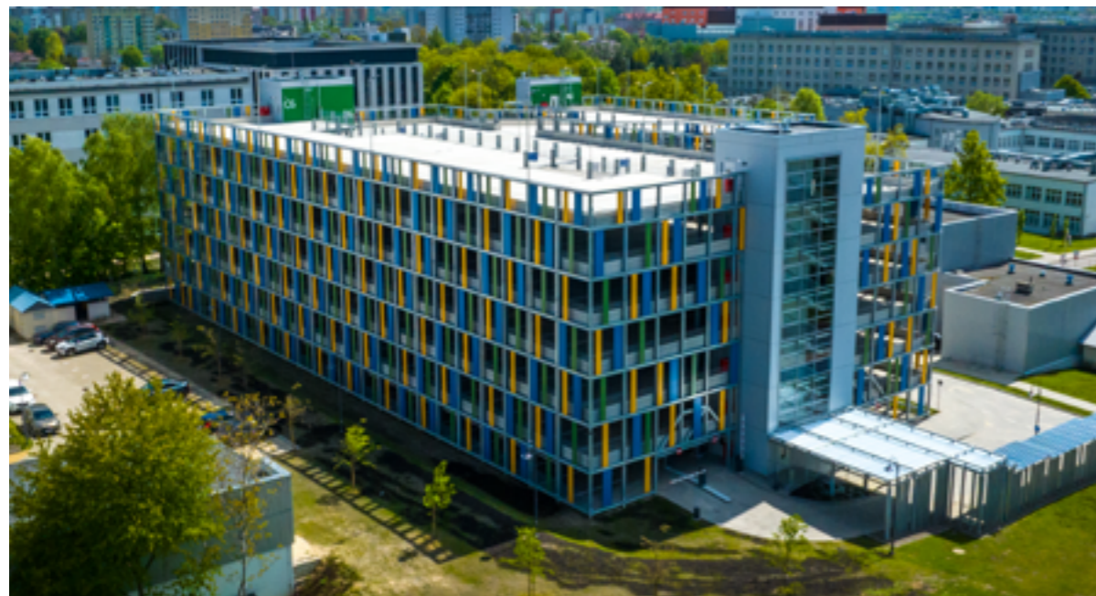
Parking wielopoziomowy dla Uniwersytetu Medycznego w Lublinie. Powierzchnia parkingu 20 000 m 2 na 7 kondygnacjach, 793 miejsca postojowe.
