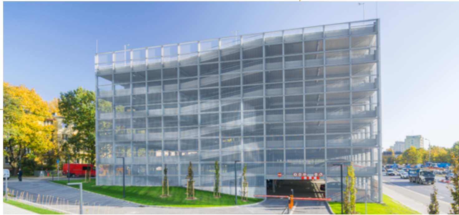
Parking wielopoziomowy dla PH Astrum w Łodzi. Powierzchnia zabudowy 2.000m 2 na 13 kondygnacjach, 341 miejsc postojowych.
