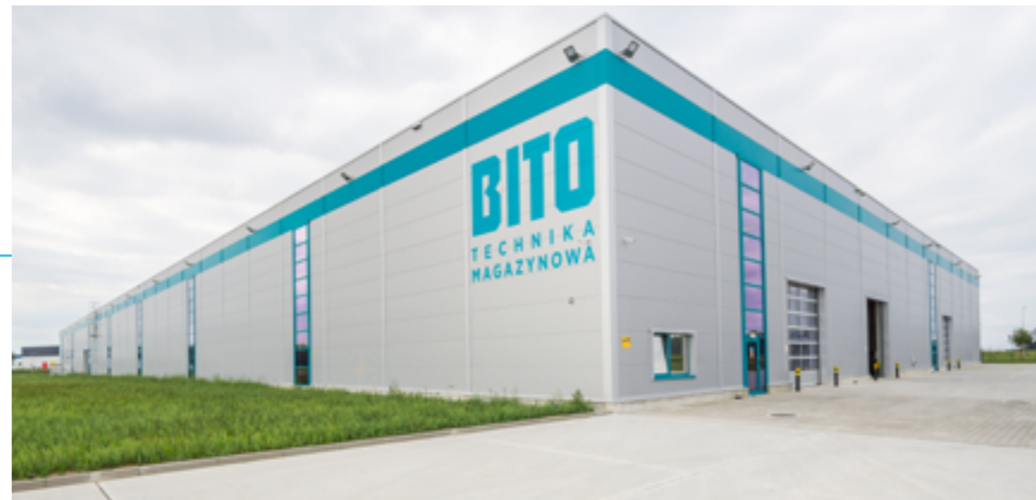
Hala produkcyjna dla BITO w Żimnej Wódce (woj. opolskie); produkcja systemów regalowych. Powierzchnia 46 000 m 2 (hala produkcyjna + magazyn + biuro).
