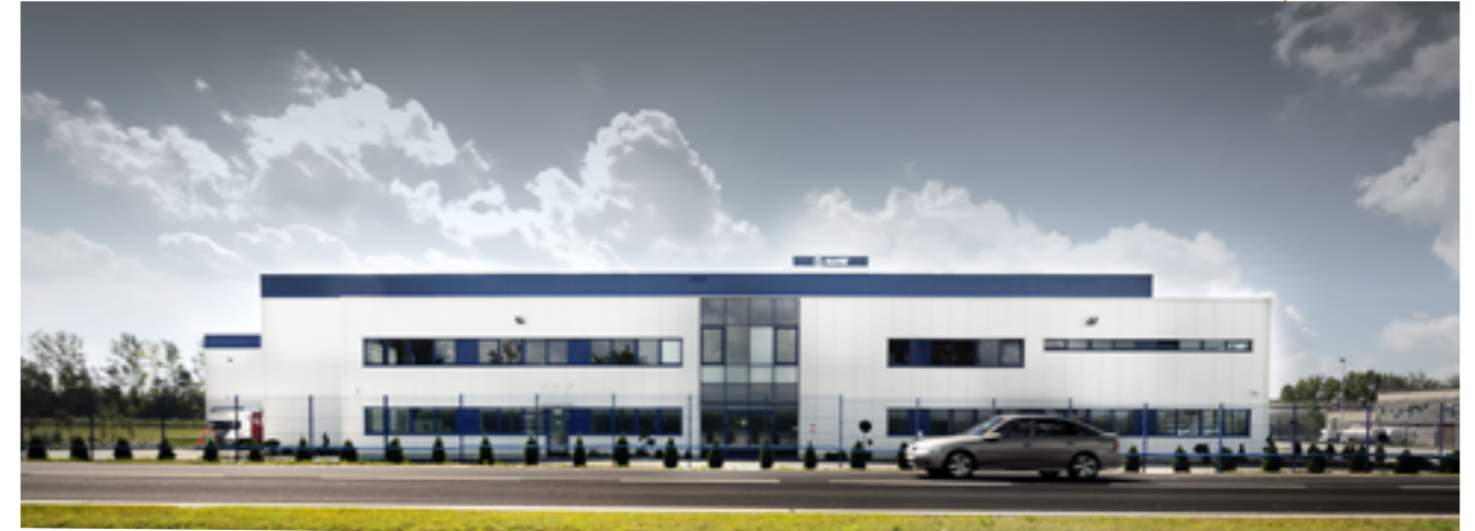
Hala produkcyjna dla Mapei w Barcinie (woj. kujawsko-pomorskie); produkcja materiałów budowlanych. Powierzchnia: 9 670 m 2 (hala + biura).
